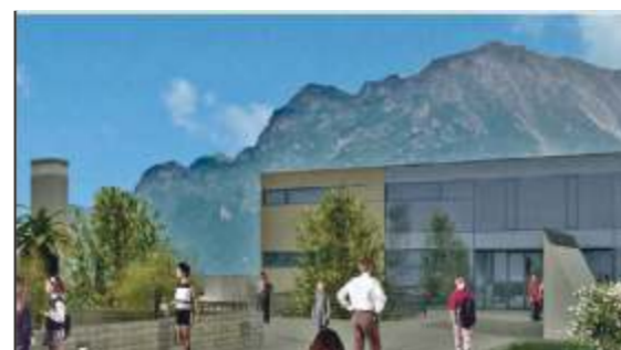
SCUOLA DI ROMARZO NEL COMUNE DI ARCO DI TRENTO IN FASE DI CERTIFICAZIONE LEED FOR SCHOOLS. L'EDIFICIO SCOLASTICO È IN FASE DI COSTRUZIONE E SARÀ CERTIFICATO LEED DA USGBC.
